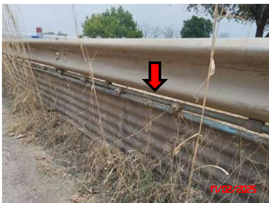
รูปที่ 9 ระบบสเปรย์น้ำล้างล้อรถบรรทุก
