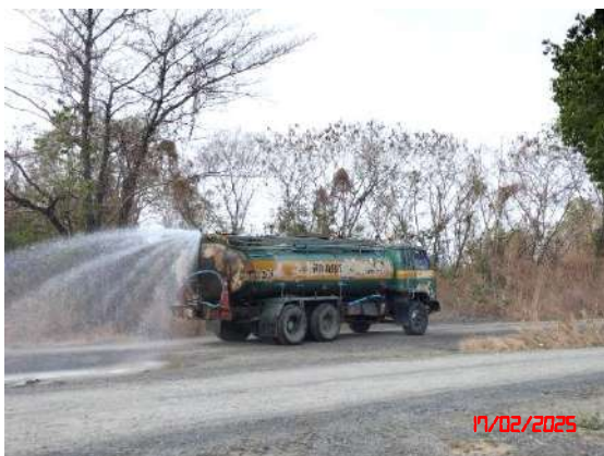
รูปที่ 6 การฉีดพรมน้ำเพื่อป้องกันและลดผลกระทบด้านฝุ่นละออง
