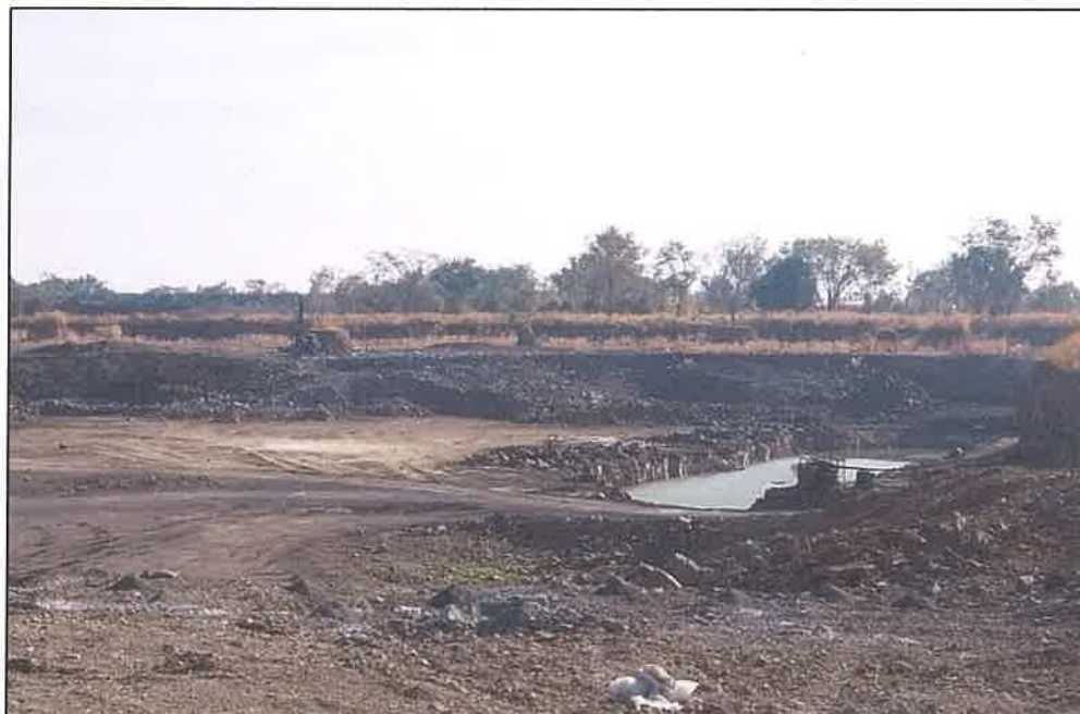
รูปที่ 2 พัฒนาหน้าเหมืองเป็นลักษณะขั้นบันไดพร้อมปรับความลาดชันให้มีความมั่นคงแข็งแรง และปลอดภัยรวมถึงการปรับสภาพเส้นทาง ขนส่งให้มีความปลอดภัยมากขึ้น
