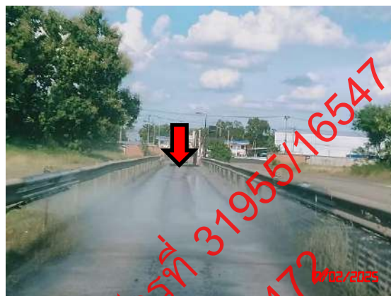
รูปที่ 9 ระบบสเปรย์น้ำล้างล้อรถบรรทุก
